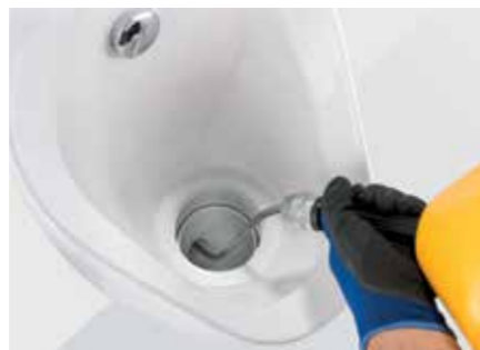
↑ Omogućen je izravan pristup sustavu odvodnje.
